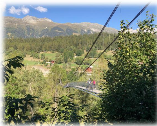
Hängebrücke im Goms
